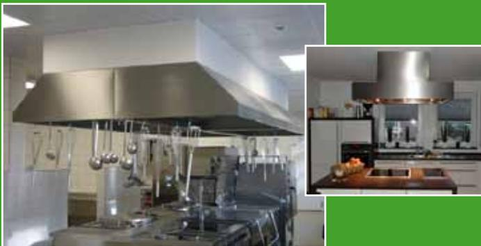
Witthaut stellt die notwendigen Hauben für die Abluftreinigungssysteme speziell zur Reduktion von Fett oder aromatischen Komponenten aus heißer Abluft her; das betrifft Brat-, Koch- und Fritierprozesse. Das System basiert auf UV-C- & Ozontechnologie. Die Grundlage dieser Methode ist die photolytische Oxidation; gemeint ist dabei eine kalte Verbrennung von organischem Material. Der Prozess hinterlässt Rückstände, die zu 100 Prozent biologisch abbaubar sind.
